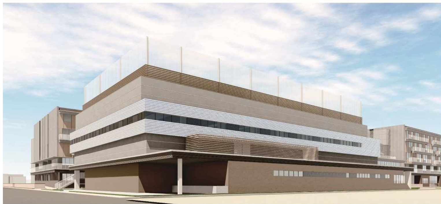
東側道路からアリーナ棟を見る / 北側に対する日影や圧迫感の軽減に配慮した層状（段状）のデザイン
